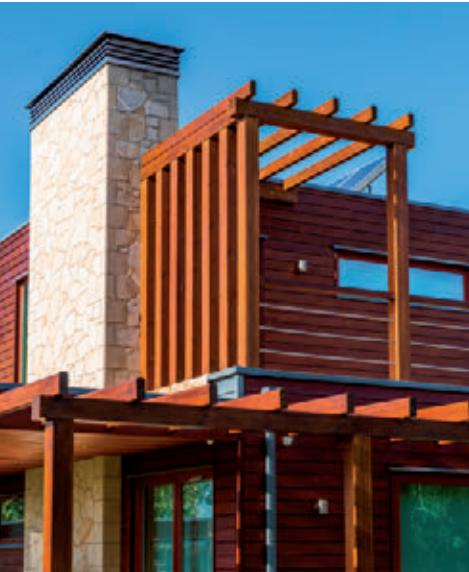
As casas em ITS™, montadas com as duas faces das paredes acabadas, podem ser entregues totalmente equipadas, com carpintaria exterior incluída, assim como os canais para instalação elétrica embutida, oferecendo uma rapidez de execução sem tempo de presa ou de secagem característico da construção húmida (construção convencional).
